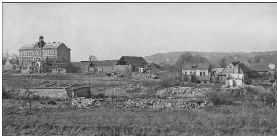
Obr. č. 67: Demolice někdejší vsi Skvrňany, konec 60. let 20. století
