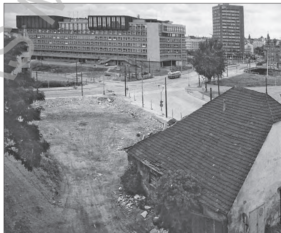
Obr. č. 72: Budova Krajské správy SNB a Hutního projektu, kolem 1983
