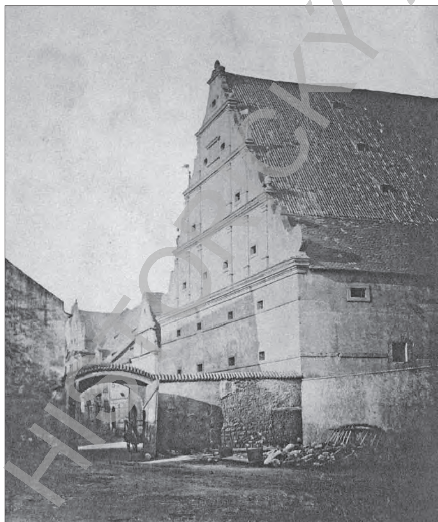
Obr. č. 18: Zbrojnice v Dlouhé (dnes Veleslavínově) ulici, před 1864
